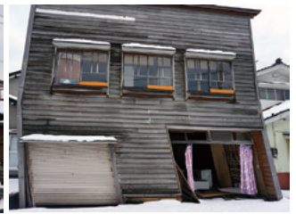
写真7 大破・倒壊した木造家屋
