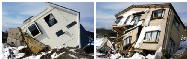
写真21 盛土の斜面崩壊による木造家屋の転倒
