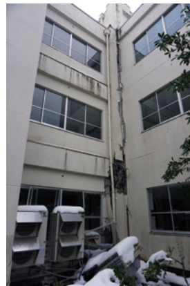
写真8 耐震補強されていた学校校舎の破壊
