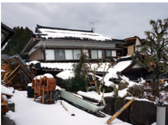
写真6 大破・倒壊した木造家屋
