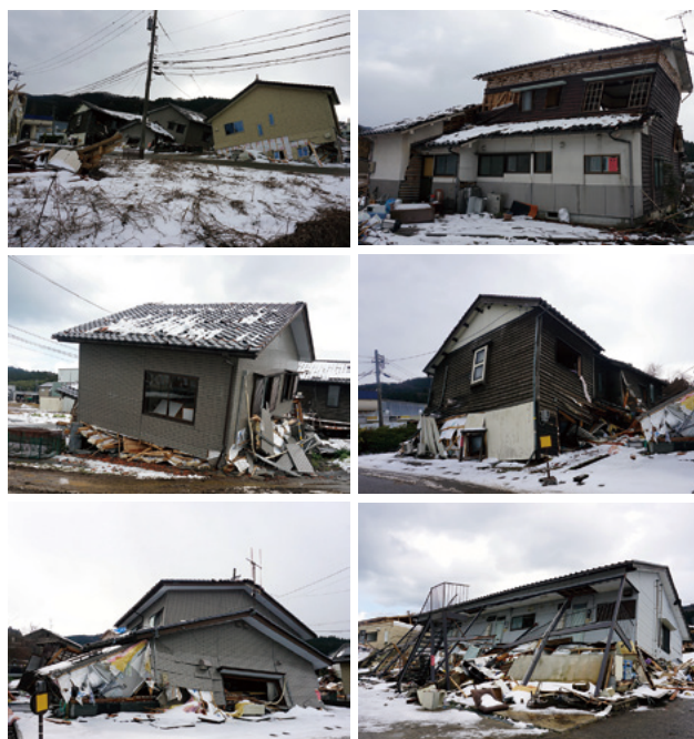
写真11 倒壊した家屋
