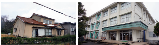
写真20 広域に地盤変状が見られた地域の建物
