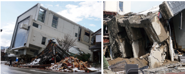
写真12 コンクリートで被覆された鉄骨柱を有する建物
