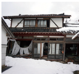
写真6 大破・倒壊した木造家屋
