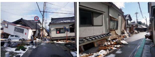
写真14 転倒したRC造ビル周辺における被害状況
