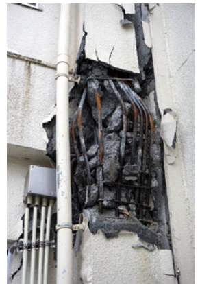
写真8 耐震補強されていた学校校舎の破壊
