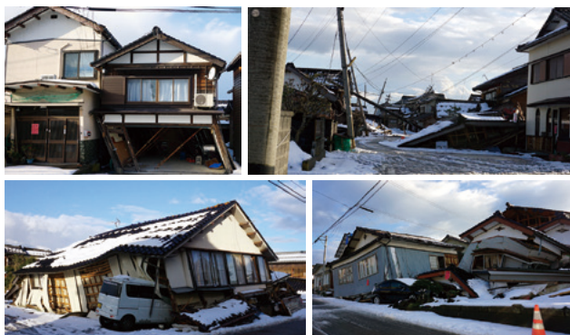
写真18 倒壊した木造家屋
