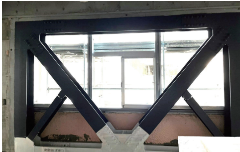
写真2 4階17通り 鉄骨ブレース施工状況
