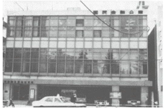
図2 地震による窓ガラスの被害 3)
