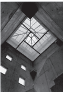
図9 日吉図書館階段天井
