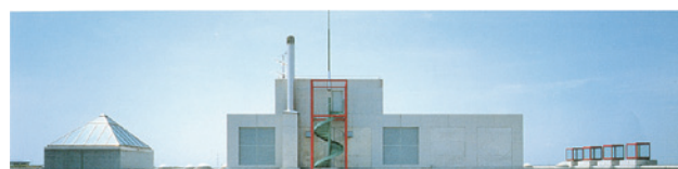
図4 慶応義塾大学日吉図書館屋上
