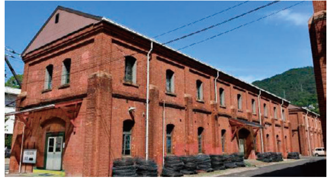
写真3 第八庫の外観を西側より見る
