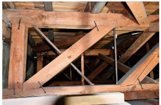
写真6 二階床の梁組（平行弦トラス）
