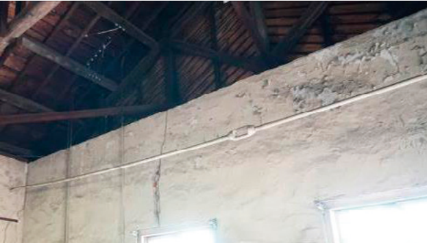
写真18 補強のために設置されたと思われる鋼棒
