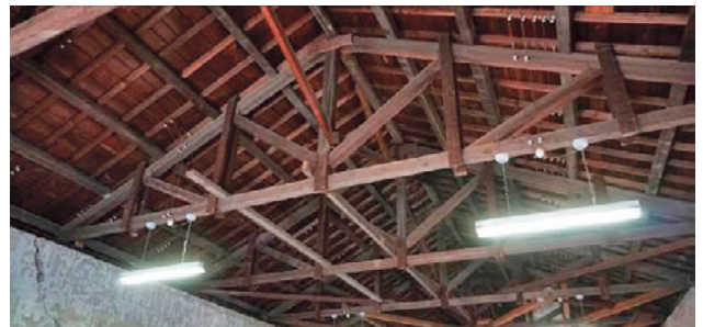
写真5 小屋組の木造トラス
