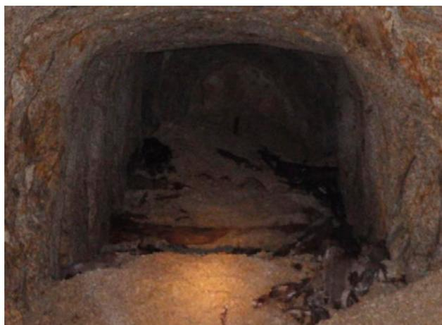
写真7 素掘りの状態で岩盤がむき出しの地下通路
