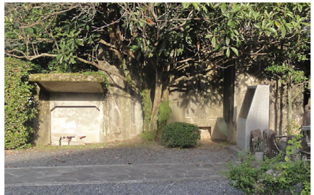
図4 防空作戦室に隣接する構造物の外観
