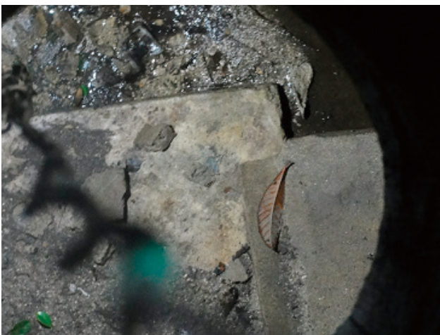
図7 防空作戦室に隣接する構造物の内部
