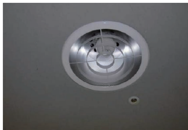
図6 (a) 第一柔道場の天井のランプ
