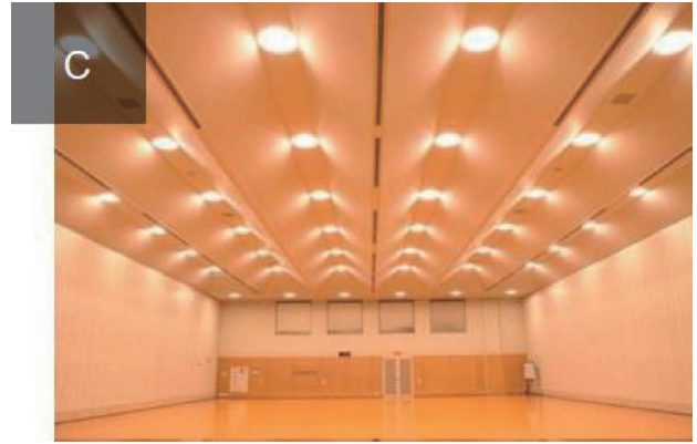
図10 (a) 施工後 第二剣道場 原画像
