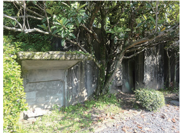
図5 防空作戦室に隣接する構造物の外観
