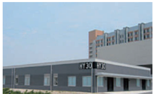
図37 水素エネルギー国際研究センター外観
