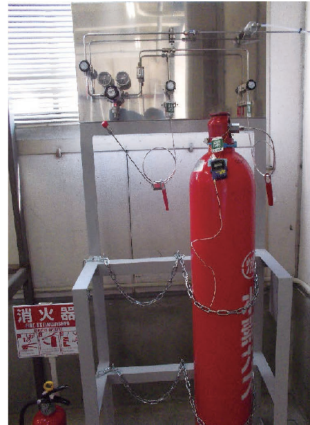
図16 供給用の水素ガスボンベ (47リットル 15 MPa)
