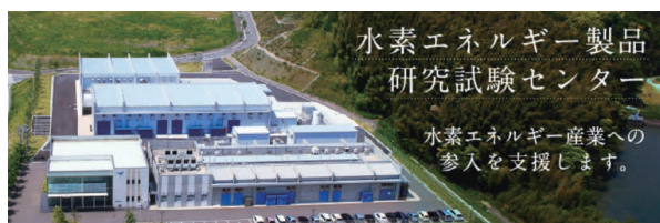
図39 水素エネルギー製品研究試験センター外観
