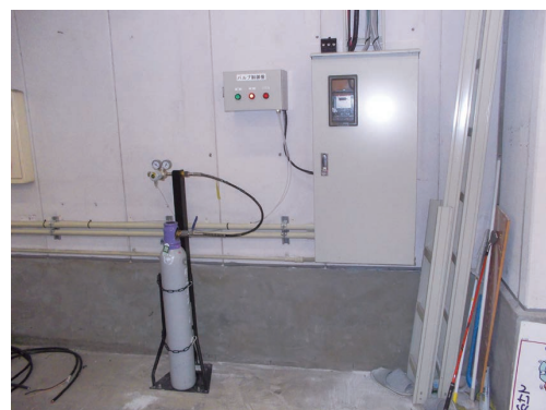
図18 遮断バルブと駆動用窒素ガス
