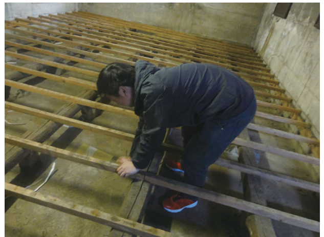
図8 打音調査の様子
