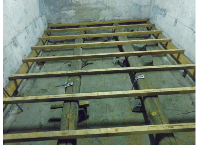
図6 防空作戦室に隣接する構造物の外観
