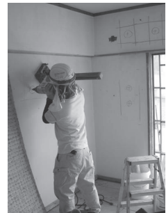
コアボーリング
