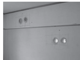
大梁と耐震壁
