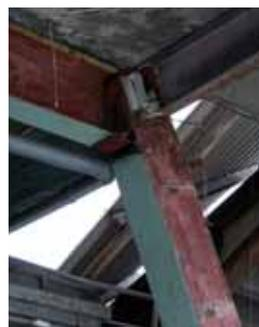
(b) 梁下フランジの破断
