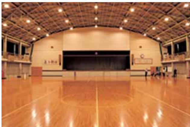
Fig. 19 盈進学園高等学校体育館施工後
