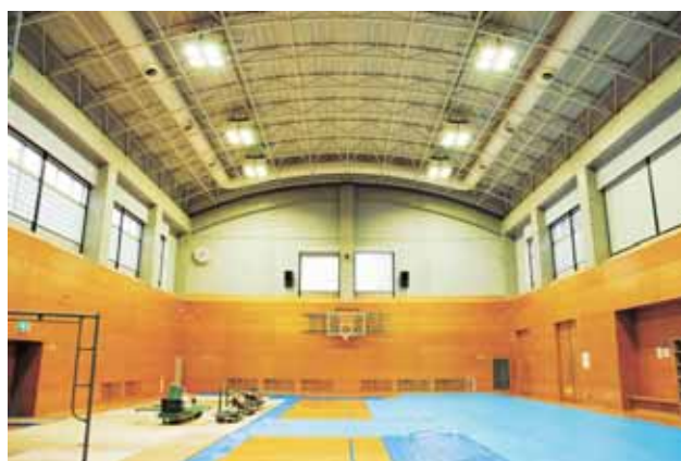
Fig. 9 水銀灯で照明されている川崎体育館
