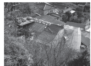
写真5 屋根の葺き替え
