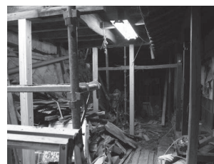
写真4 柱の交換作業
