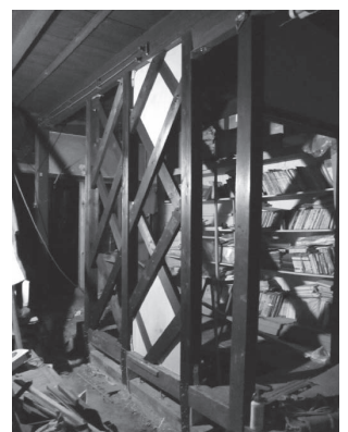
写真7 耐力壁の完成
