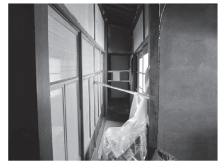
写真3 北面張り出し部
