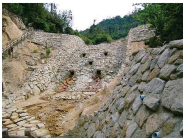
Fig6.7 1号堰堤の現場写真
