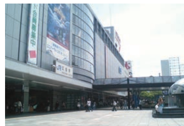
図3 広島駅南口の様子
