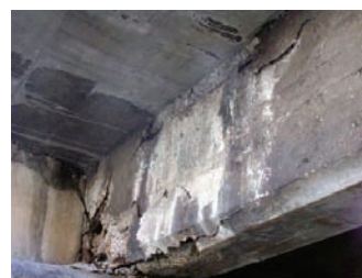
写真-2 健全度 2 の RC 主桁
