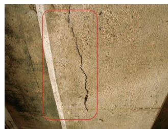
写真-1 健全度 3 の RC 主桁
