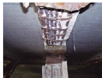
写真-3 健全度 1 の RC 主桁
