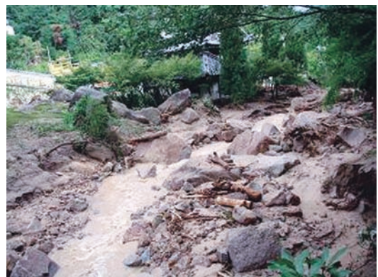
Fig3.3 被害状況（被災直後の様子）
