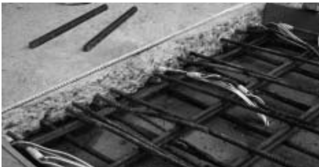
(c) 床スラブ打ち継ぎ面
