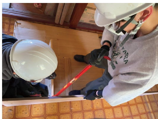
図5 家具の解体作業の様子
