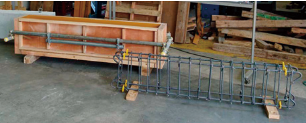
写真5 型枠と鉄筋
