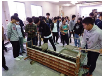
写真6 コンクリートの受け入れ検査と打込み
