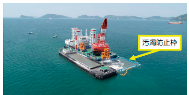
図5 グラブ浚渫状況
