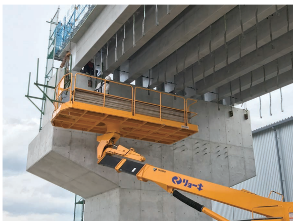
図15 PC桁設置状況（廿日市側・12月7日）
