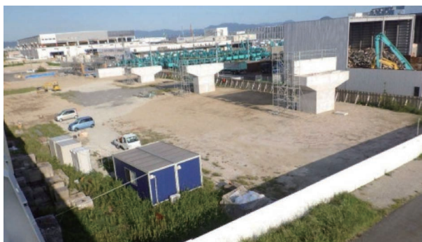
図12 五日市側下部工工事完了写真10月（提供：広島県）
