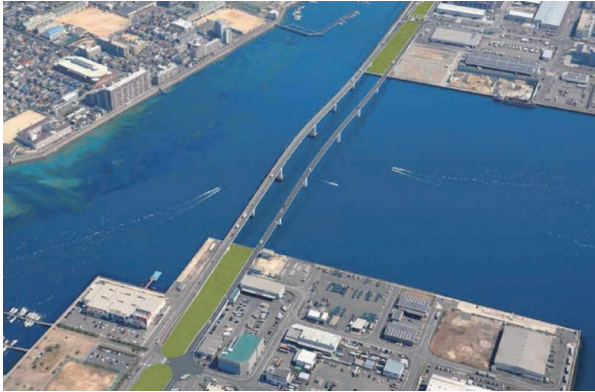
図1 臨海道路廿日市草津線整備事業計画図（提供：広島県）
