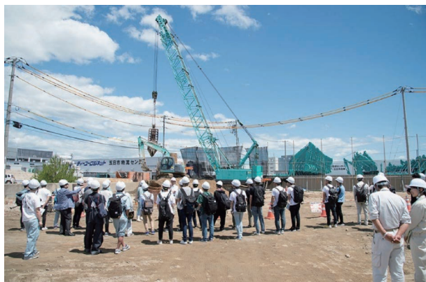
図7 A1の基礎工（杭うち）の見学
