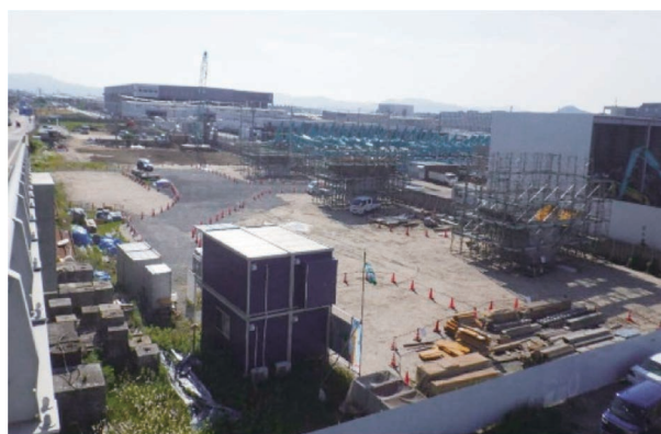
図5 五日市側陸上部下部工の工事写真（提供：広島県）
