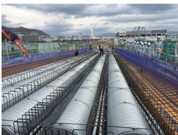
図16 五日市側上部工工事見学の様子（12月7日）
