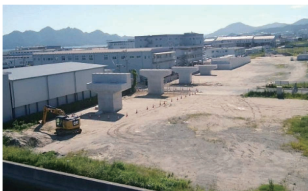
図13 廿日市側下部工工事完了写真10月（提供：広島県）
